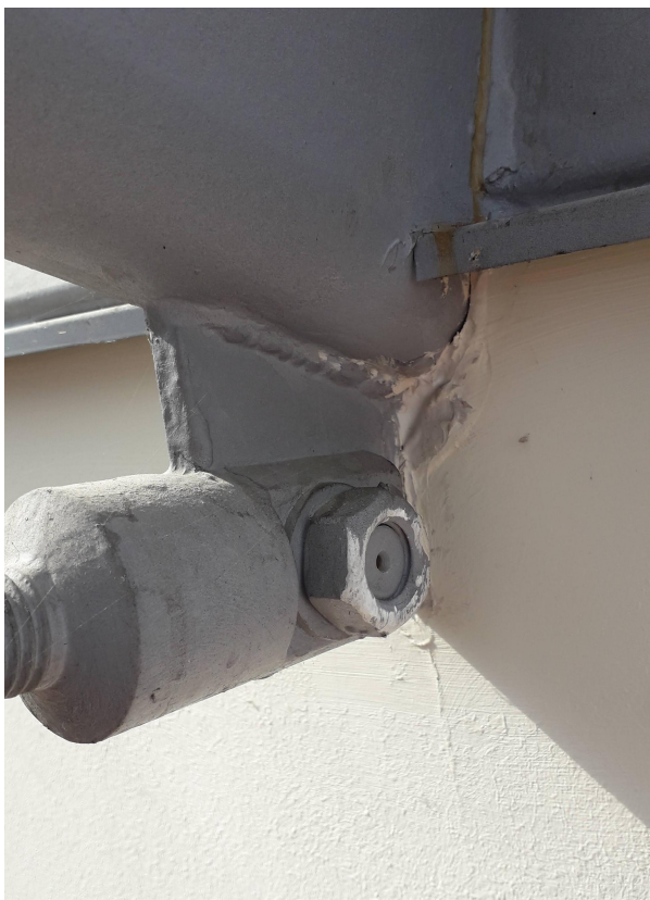
Obr.6: Kotvení hlavního táhla
