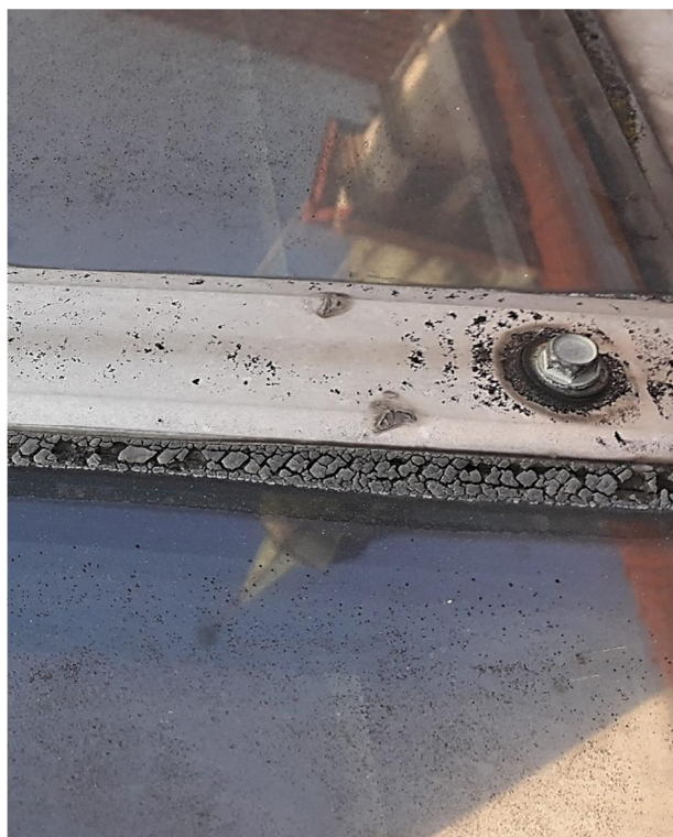
Obr. 13: Havarijní stav zasklení, ve 4 tabulích skla se nachází voda; těsnění horních spár je na konci své životnosti
