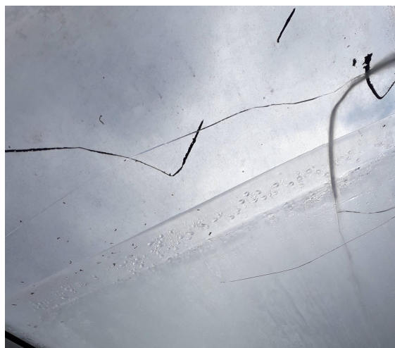
Obr. 12: Prasklá tabule skla, vyplněná vodou
