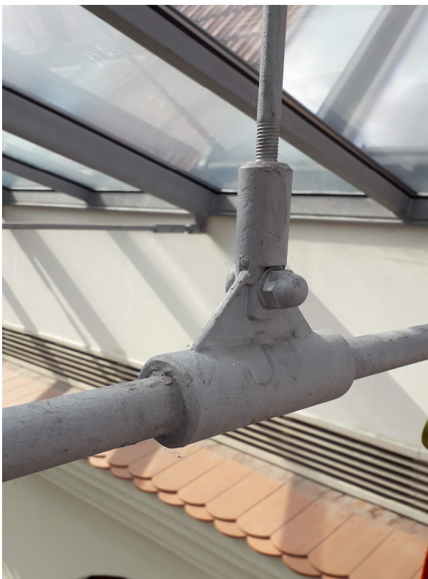
Obr. 7: Závěs hlavního táhla
