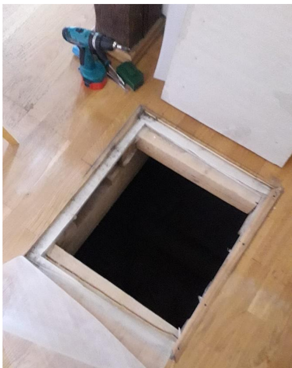
Obr. 14: Průzkum nadezdívky – vstup do prostoru pod podlahou, nadezdívka (římsa) z vnitřní strany
