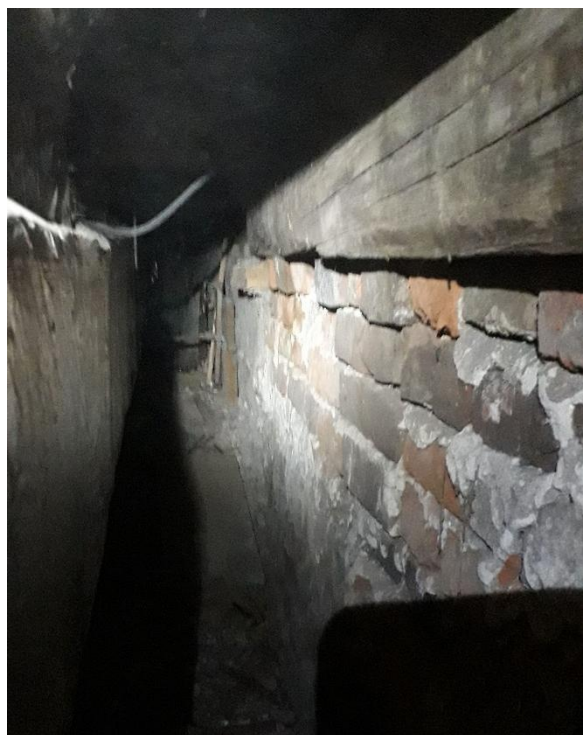
Obr. 14: Průzkum nadezdívky – vstup do prostoru pod podlahou, nadezdívka (římsa) z vnitřní strany
