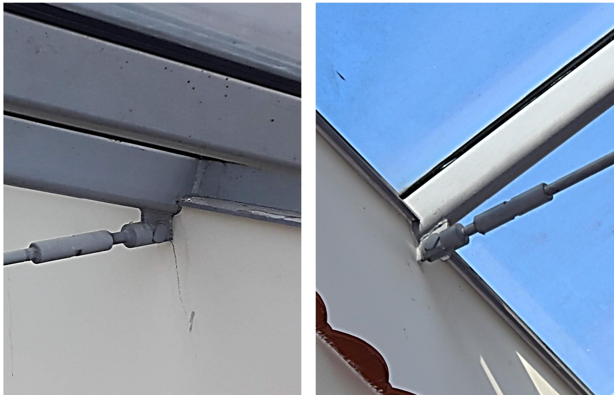
Obr. 15: Nepřístupný detail uložení, vizuálně bez závad. V jednom místě patrné trhliny v SDK
