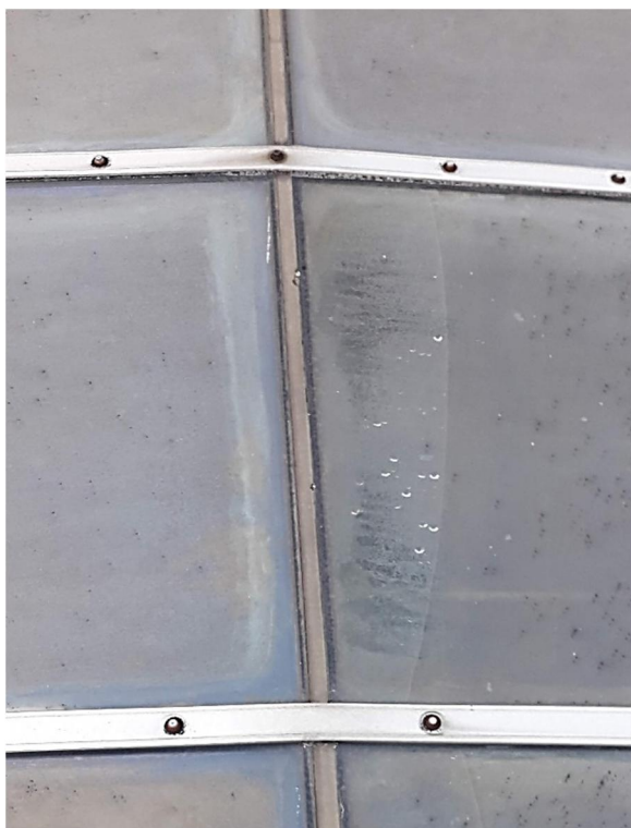
Obr. 13: Havarijní stav zasklení, ve 4 tabulích skla se nachází voda; těsnění horních spár je na konci své životnosti
