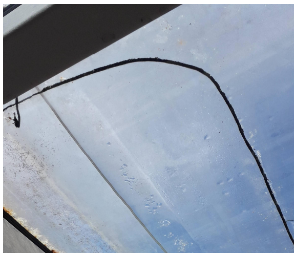
Obr. 12: Prasklá tabule skla, vyplněná vodou
